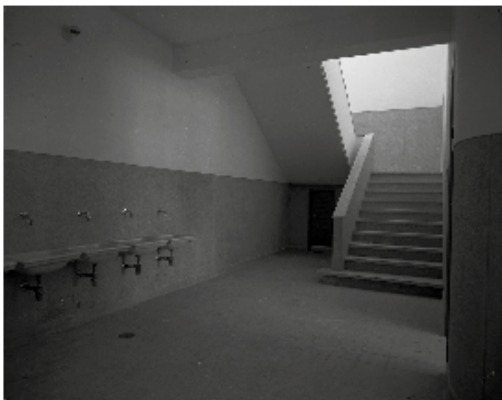
Figura 52 Lavabos na Escola Primária Bartolomeu de Gusmão, atual Escola Básica do 2º Ciclo do Padre Bartolomeu de Gusmão situada na rua Bela Vista à Lapa, fotografia de Armando Maia Seródio, 1956. Arquivo Municipal de Lisboa, PT/AMLSB/CMLSBAH/PCSP/004/SER/001183.
