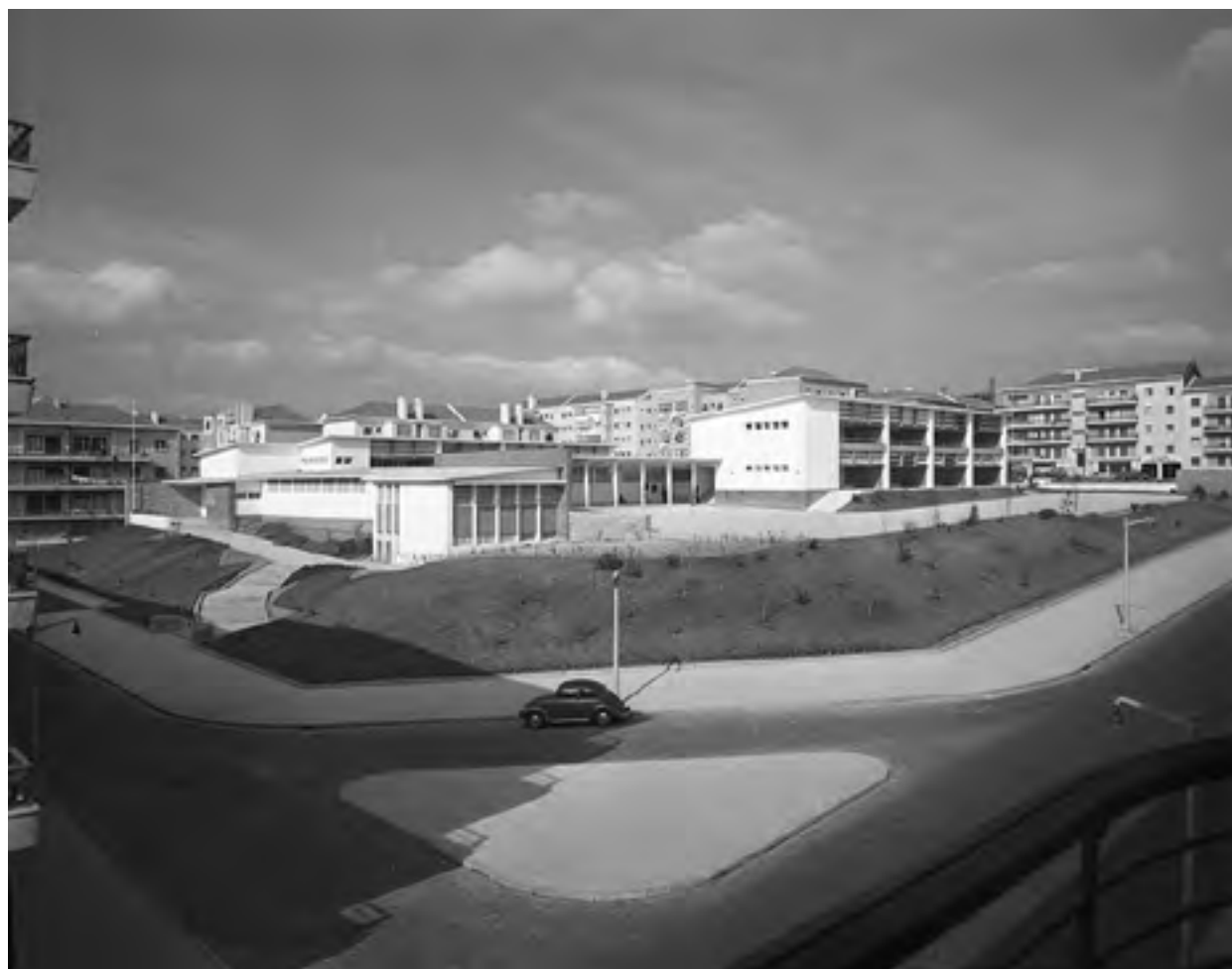
Figura 32 Escola Primária Nº 24, atual Escola Básica do 1.º Ciclo do Bairro de São Miguel, situada na rua António Ferreira de Vasconcelos, fotografia de Armando Maia Seródio, 1956. Arquivo Municipal de Lisboa, PT/AMLSB/CMLSBAH/PCSP/004/SER/001139.
