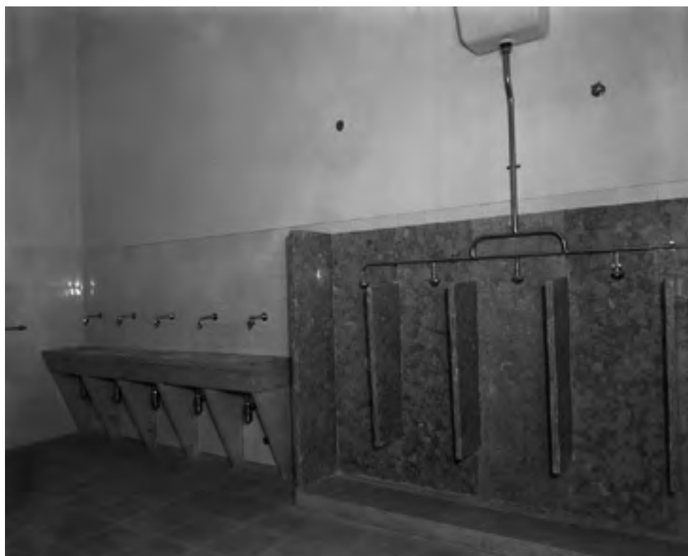
Figura 56 Instalações sanitárias da Escola Primária do Bairro Santos, atual Escola Básica Mestre Arnaldo Louro de Almeida, situada na rua Diogo de Macedo, fotografia de Armando Maia Seródio, 1954-10-28. Arquivo Municipal de Lisboa, PT/AMLSB/CMLSBAH/PCSP/004/SER/001152.
