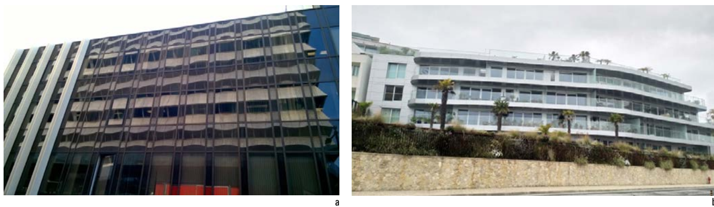
Figura 10 Aplicação típica do alumínio em componentes de fachada – caixilharia: a. Edifício de escritórios em ambiente urbano, Lisboa. Alumínio anodizado cor bronze, década de 1980; b. Edifício de habitação em ambiente marítimo, Cascais. Alumínio anodizado cor natural, 2018. Fotografias da autora.
