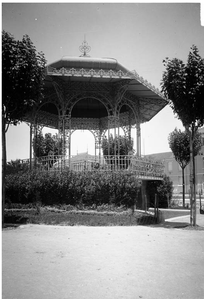
Figura 1 Exemplos de utilização de materiais ferrosos em edifícios habitacionais e de lazer antigos: a. Edifício de janelas com varandas de sacada em ferro forjado, Bairro Alto, Lisboa, fotografia de Armando Maia Serôdio, 1959. AML, PT/AMLSB/CMLSBAH/PCSP/004/SER/002091; b. Gradeamentos e caixilharias em ferro forjado em moradia de estilo “Arte Nova”, Casa-Museu Doutor Anastácio Gonçalves, Avenidas Novas, Lisboa, fotografia de Alberto Carlos Lima, [entre 1905 e 1949]. AML, PT/AMLSB/CMLSBAH/PCSP/004/LIM/000896; c. Terraço com gradeamento nas plataformas e estufa do palacete Ribeiro da Cunha, Lisboa, [194-]. AML, PT/AMLSB/CMLSBAH/PCSP/004/ACU/002535; d. Estufas no jardim da quinta das Laranjeiras, Lisboa, fotografia de José Artur Leitão Bárcia, [entre 1890 e 1945]. AML, PT/AMLSB/CMLSBAH/PCSP/004/BAR/000537; e. Coreto da Praça José Fontana, Lisboa, fotografia de José Artur Leitão Bárcia, [entre 1900 e 1945]. AML, PT/AMLSB/CMLSBAH/PCSP/004/BAR/000828.
