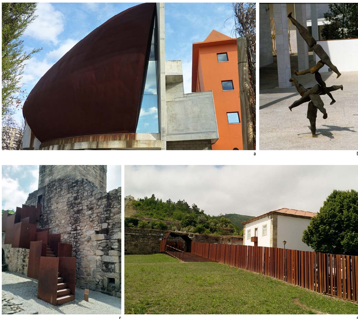
Figura 6 Exemplos de aplicações dos aços patináveis em arquitetura: a. Revestimento de cobertura, Igreja Paroquial de S. Francisco Xavier, Lisboa/Restelo. Fotografia da autora; b. Escultura “Rizome” de Antony Gormley, Parque das Nações, Lisboa, Tiago Venâncio, 1998-06-20. AML, PT/AMLSB/PAE/GFOT/01/040/009487; c. e d. Sistemas de acesso em património reabilitado. Fotografias da autora.
