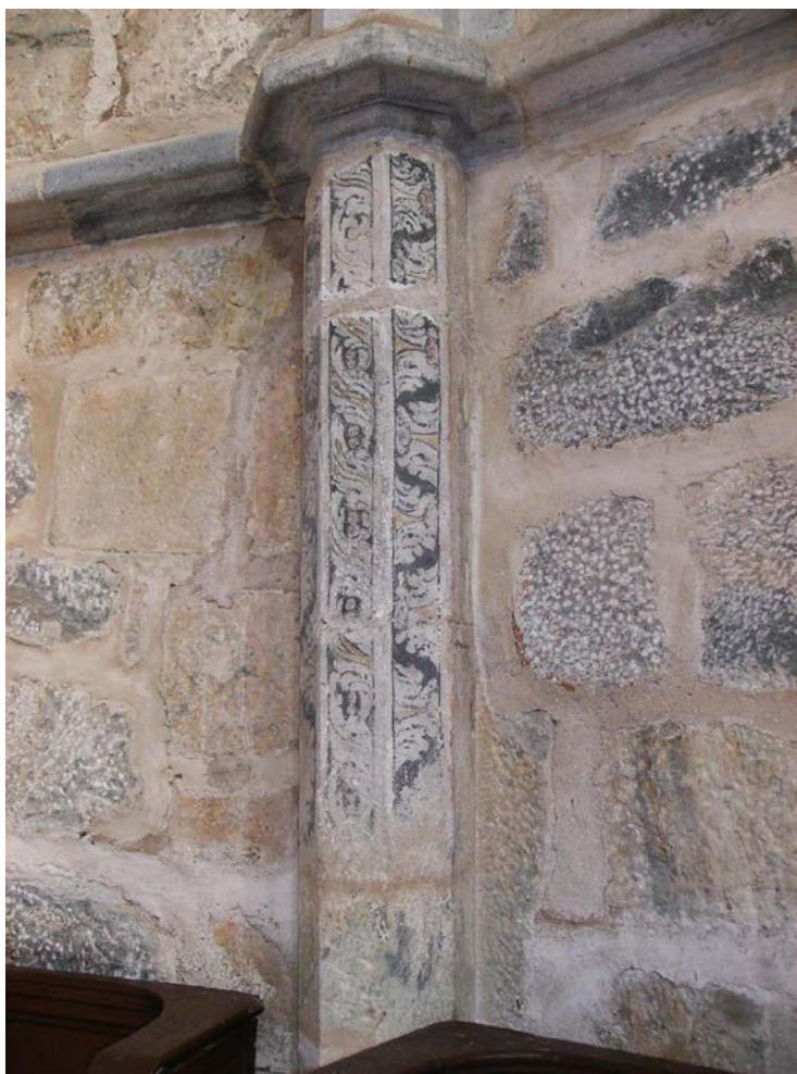
Figura 5 Pintura de fingimento de embutidos de mármore sobre granito, Igreja do Convento de S. Domingos, Elvas, século XVIII(?). Fotografia da autora.
