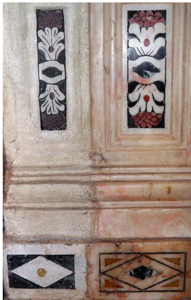
Figura 6 Pintura de fingimento de embutidos de mármore, Igreja de S. Bartolomeu, Vila Viçosa, século XVIII. Fotografia da autora.
