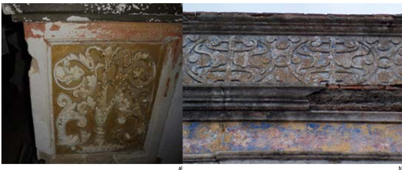
Figura 4 Exemplos de efeitos decorativos em argamassas com base em cal: a) fingidos em estuque numa igreja no Algarve (janeiro 2018); b) stucco de argamassa de cal em platibanda de edifício do Centro Histórico de Palmela (junho 2006). Fotografias de Maria do Rosário Veiga.
