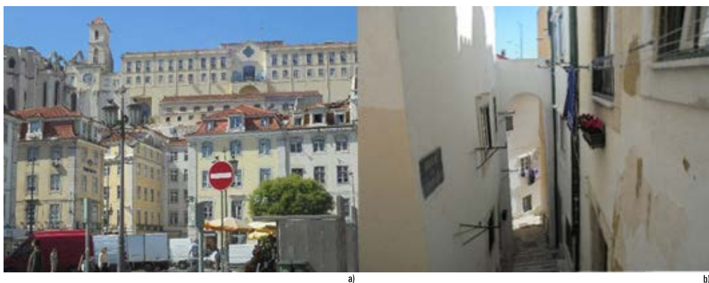
Figura 2 Argamassas de cal na estrutura de edifícios do Centro Histórico de Lisboa: a) Rossio e ao fundo, em cima, o Convento do Carmo (março 2019); b) Bairro de Alfama – Beco da Cardoso (março 2019). Fotografias de Maria do Rosário Veiga.
