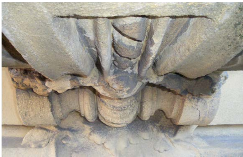
Figura 12 Elementos decorativos fingindo pedra em argamassa de cimento natural. 2009. Fotografia de Ana Velosa.
