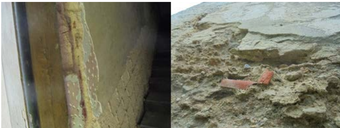
Figura 3 Exemplos de revestimentos de argamassas de cal aplicadas em várias camadas (janeiro 2019). Fotografias de Maria do Rosário Veiga.
