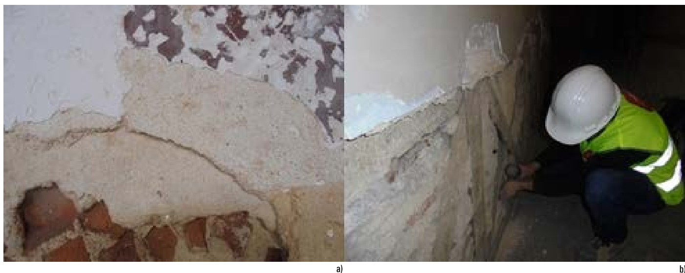
Figura 1 Argamassa de cal aglutinando: a) pedra e elementos cerâmicos (janeiro 2019); b) elementos de madeira numa gaiola pombalina (janeiro 2019). Fotografias de Maria do Rosário Veiga.
