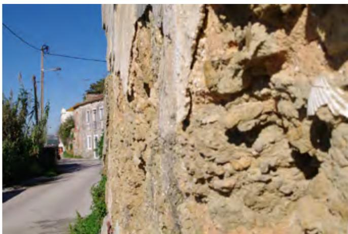
**Figura 1** Aspeto de parede em alvenaria de calcário conquífero marinho miocénico local, Fonte Santa, 2010. Arquivo Fotográfico do Centro de Arqueologia de Almada, Dig.11321.
