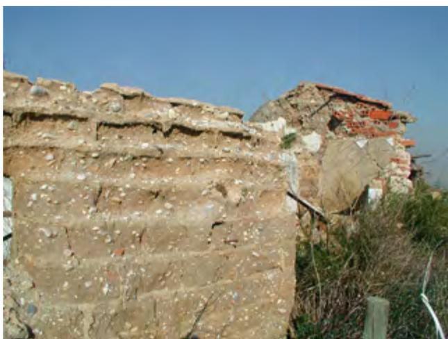
**Figura 7** Parede em adobe, Charneca de Caparica, 2008.
