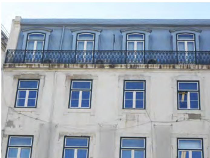
**Figura 5** Mansarda em chapa ondulada galvanizada, acrescentada em 1904, sobre edifício na Praça do Município, 14 a 19 (AML, Obra n.º 13500), com projeto do construtor João Baptista dos Reis. Fotografia dos autores, 2020.
