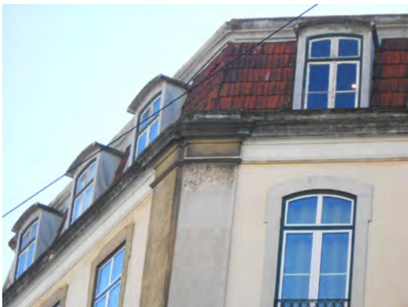
**Figura 7** Mansardas em telha Marselha, acrescentada em 1885 sobre edifício na Rua dos Fanqueiros, 107 a 111, com a Rua de São Nicolau, 1 a 17, e Rua dos Douradores, 38 a 48 (AML, Obra n.º 13500). Fotografia dos autores, 2020.
