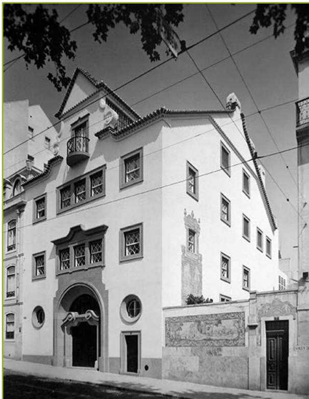
Figura 1 Vista do exterior. Fotografia de Horácio Novais, c.1953. Arquivo da Família Vasco Rebelo de Andrade (ARQFVRA), s/c.
