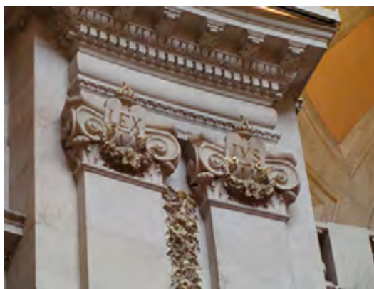
Figura 8 Sala das Sessões, capitéis de pilastra em Mármore de Estremoz, 2019. Fotografia das autoras.
