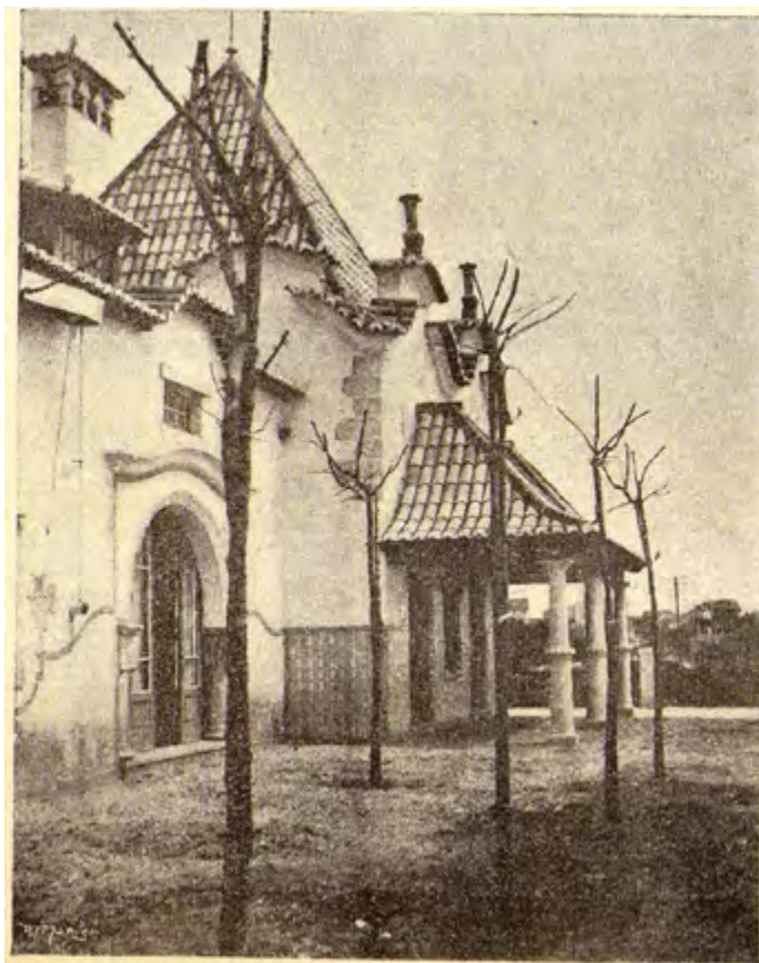
Figura 2 Casal de São Roque, fachada sul. (A Construção Moderna, 1904a).
