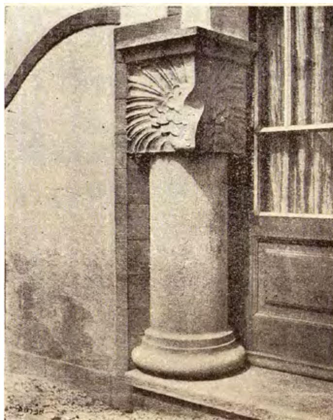
Figura 3 Casal de São Roque, detalhe de cantaria da moldura da uma porta. (A Construção Moderna, 1904a).
