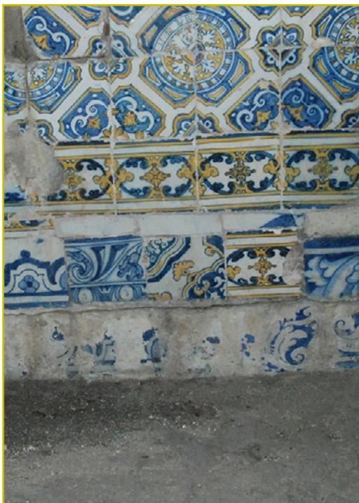
**Figura 15** Quarto momento do revestimento azulejar: após a descoberta do pavimento em pedra original, este foi destapado e o espaço entre o pavimento e os azulejos preenchido com azulejos de várias épocas. Este momento pode ser datado de entre os finais do século XIX até ao primeiro quartel do século XX. Fotografia do autor, 28-11-2013.
