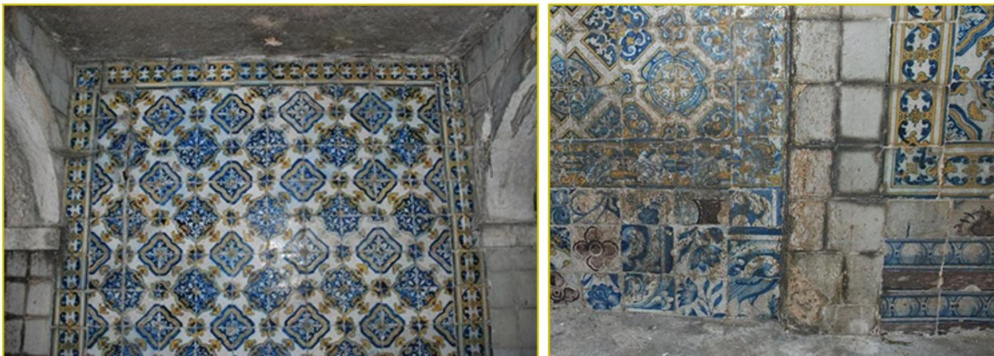
**Figuras 11 e 12** Segundo momento do revestimento azulejar: azulejos de padrão tapete e cercadura, datáveis da primeira metade do século XVII, que foram aplicados tendo em conta um pavimento mais elevado. Fotografias do autor, 28-11-2013.
