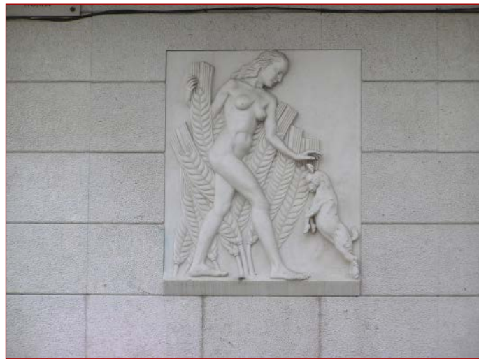
Figura 2 Relevo de pedra de Stela de Albuquerque em edifício da avenida de Roma, n.º 40, 1953. Fotografia da autora.
