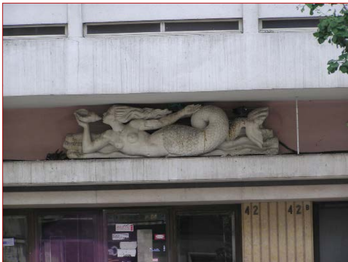
Figura 3 “Entalado” de autor anónimo em edifício da avenida de Roma, n.º 42 (arq. Sérgio Botelho de Andrade Gomes, c. 1955. Fotografia da autora.
