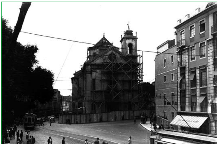
Figura 2 Igreja de Nossa Senhora do Socorro em processo de demolição, Eduardo Portugal. AML, PT/AMLSB/POR/019588.
