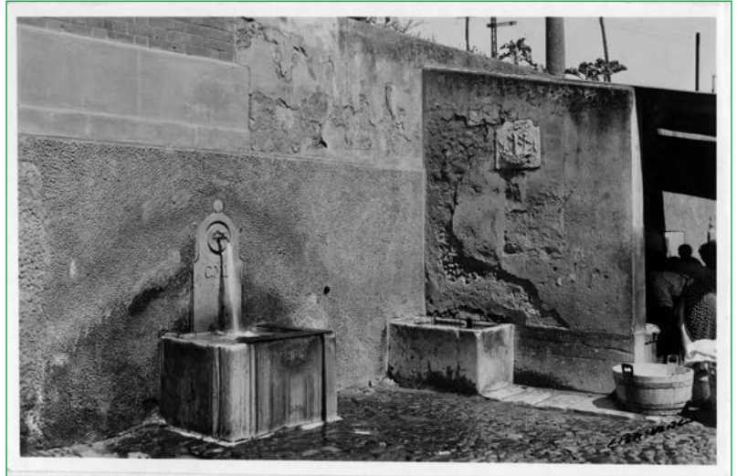
Figura 6 O chafariz de Xabregas e o lavadouro em 1939, Fotografia de Eduardo Portugal. AML, PT/AMLSB/CMLSB/PCSP/004/EDP/001930.
