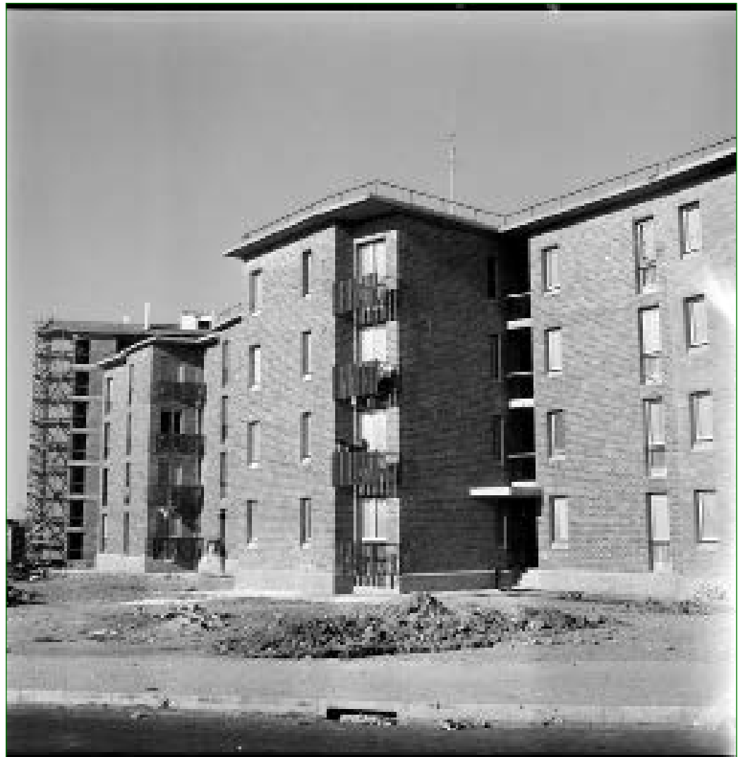
Figura 9 Edifício de Croft, Morais e Cadima, fotografia de Arnaldo Madureira, 1965. AML, PT/AMLSB/CMLSB/PCSP/004/ARM/004179.
