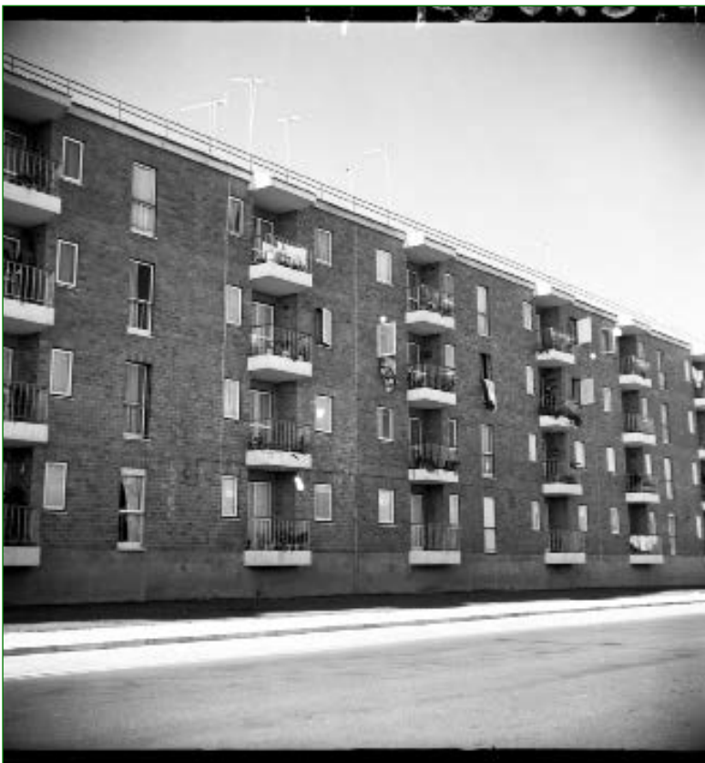
Figura 5 Edifício de Braula Reis e Matoso, fotografia de Vasco Gouveia de Figueiredo, 1968. AML, PT/AMLSB/CMLSBAH/PCSP/004/VGF/001271.
