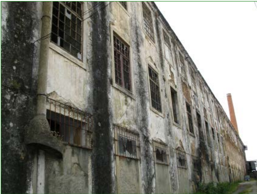
Figura 14 Edifício da Fábrica da Samaritana (Fiação e Tecidos Lisbonense), 2012. Fotografia da autora
