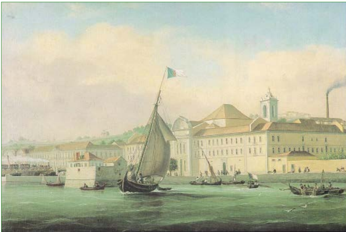
Figura 2 Fábrica de Tabaco no antigo Convento de S. Francisco. Na imagem, a par da proximidade do rio, são já visíveis uma longa chaminé industrial e o comboio a vapor. A antiga Fábrica de Tabacos de Xabregas . Óleo s/ tela, João Pedrozo, 1270 mm x 835 mm, 1859. Museu de Lisboa, Palácio Pimenta, MC.PIN.316.
