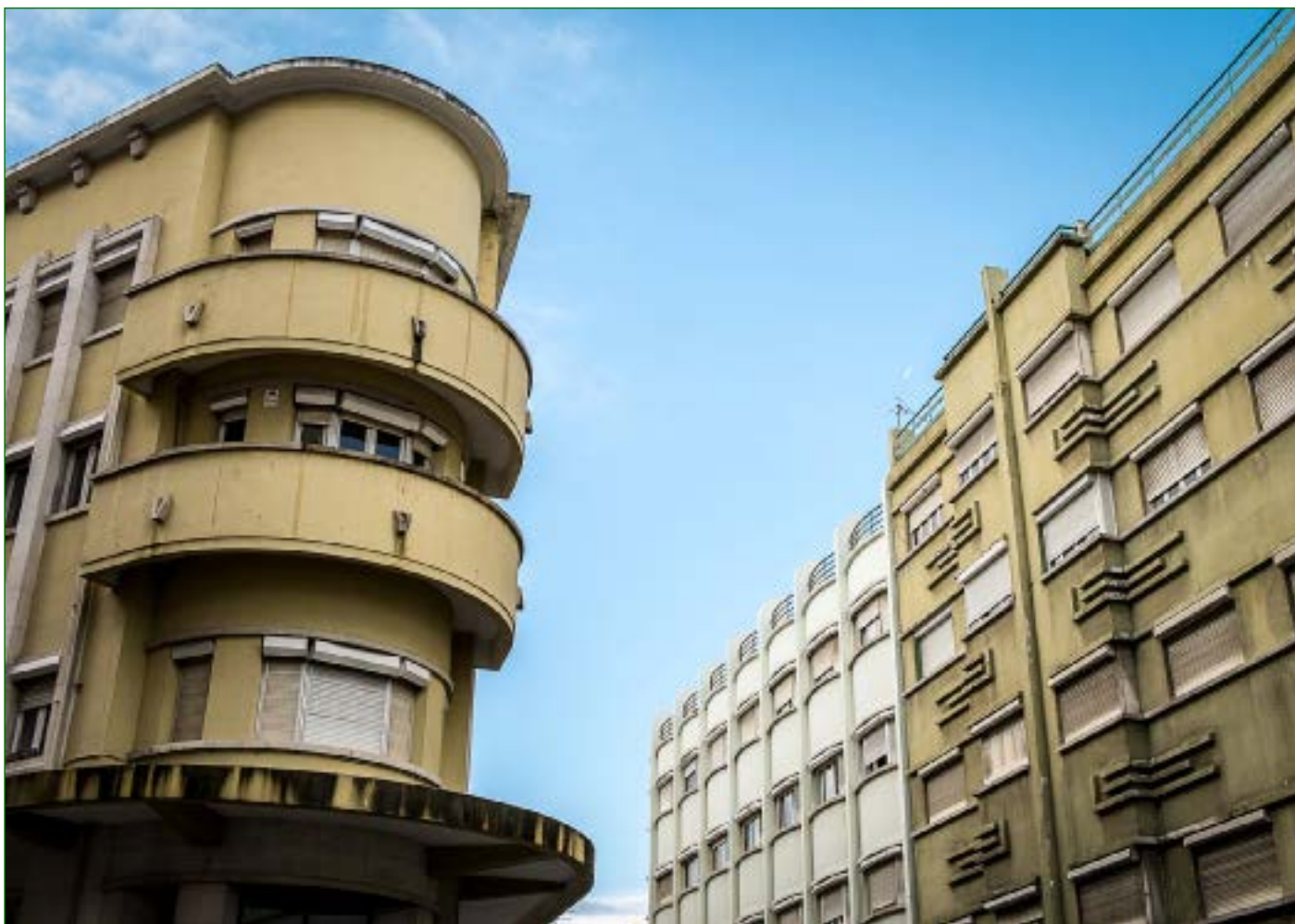
Figura 13 Bairro das Colónias. Rua Palmira gaveto com a Rua Forno do Tijolo. CML, DMC, DPC. José Vicente, 2013.
