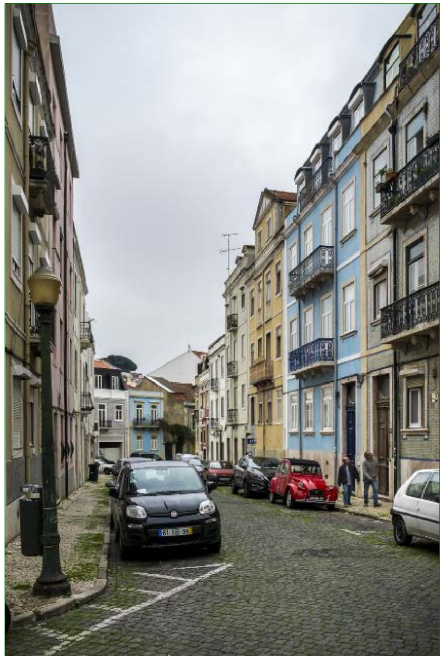
Figura 6 Bairro dos Castelinhos. Rua Rafael de Andrade. CML, DMC, DPC. José Vicente, 2016.
